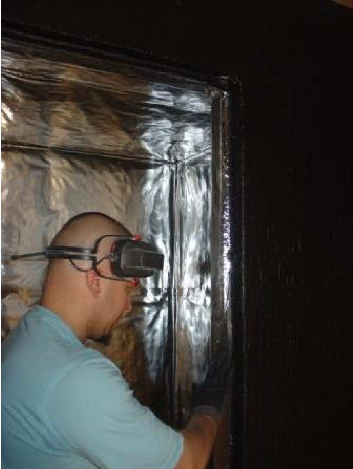
Teippaus tehdään oviaukon reunassa olevaan vesieristeeseen saakka
