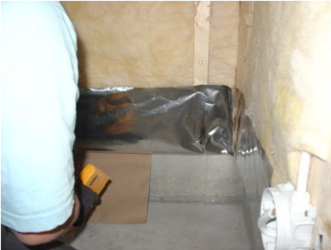
Alumiinipaperin asennus alareunassa (vaihtoehto 1)
