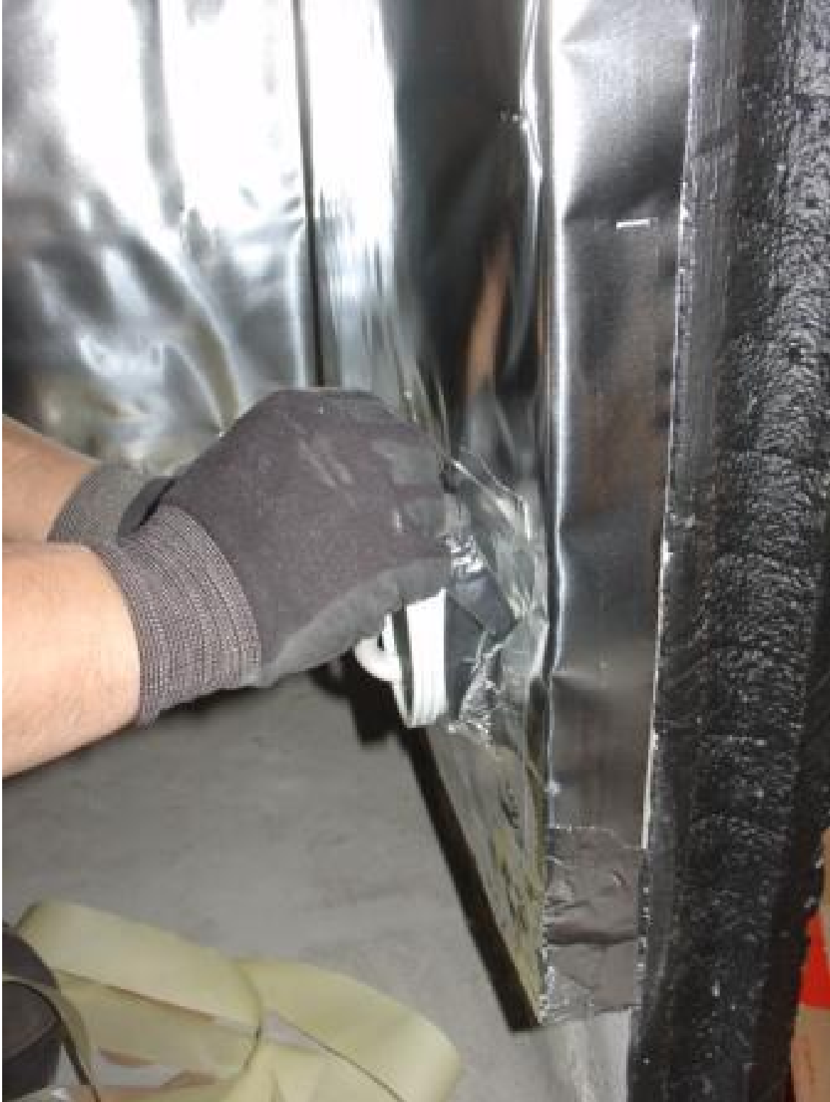
Sähkörasioiden reunat on teipattava tiiviisti
