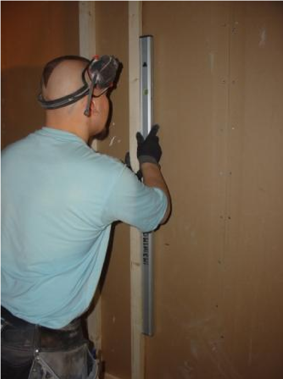
Seinän runkotolppien asennus
